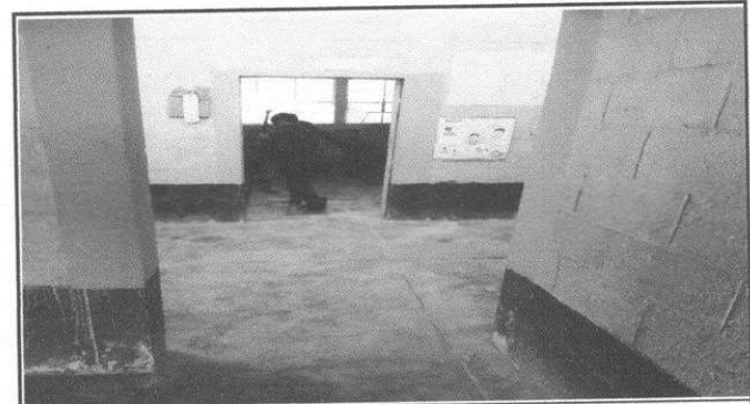
Foto 4: Se observa la sustitución del piso de la bodega.
